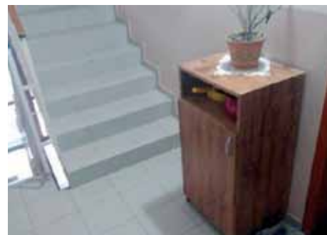
Zjištěná závada z požární kontroly
