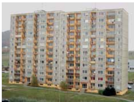
sam. 275 sídliště Špičák, Česká Lípa před zateplením
